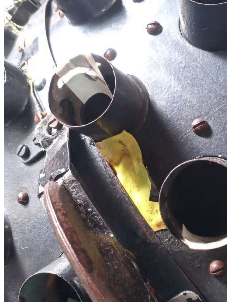
Bild 5. Verwendung von unterschiedlichen Klebebändern zur Sicherung der Elektrifizierung.
